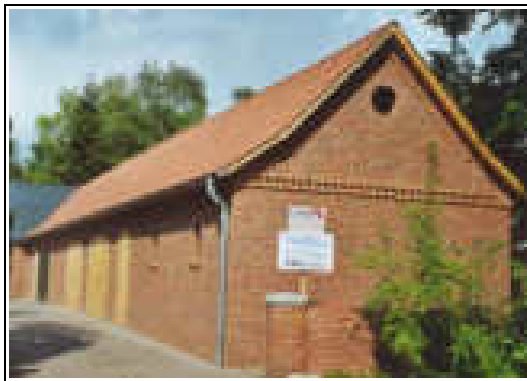
Stallgebäude/Garage in Armsen
