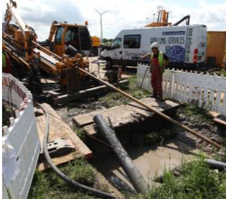
Geschlossene Verlegeweise (z.B. Horizontalspülbohrung; Microtunnel)
