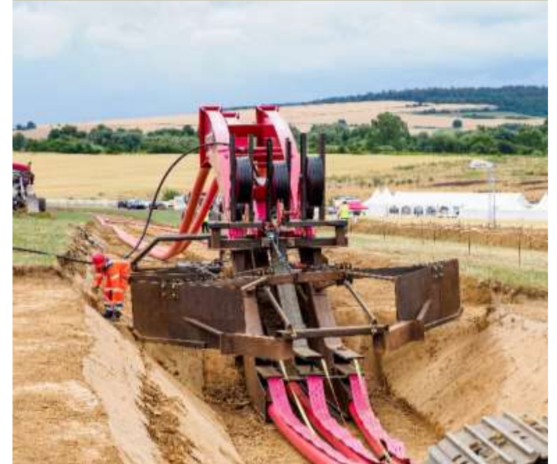
Sonstige Verlegeweisen (z.B. Fräsverfahren; Pflugverfahren (im Test))
